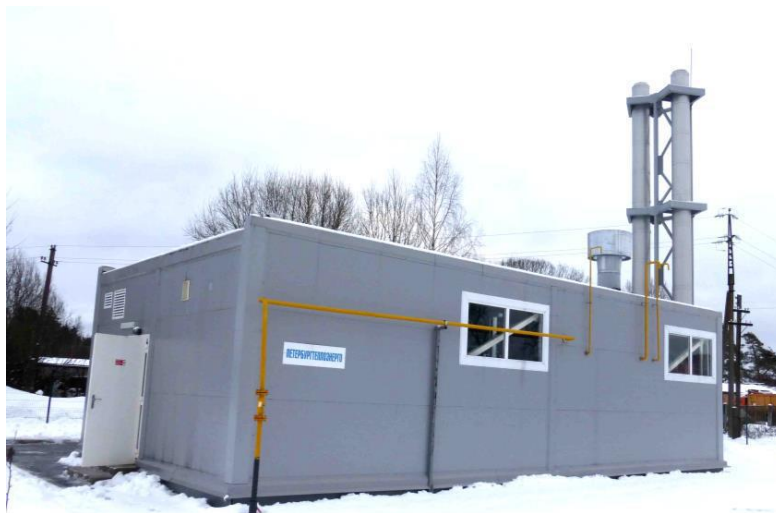
Рисунок 3 – Внешний вид котельной д. Каменка
