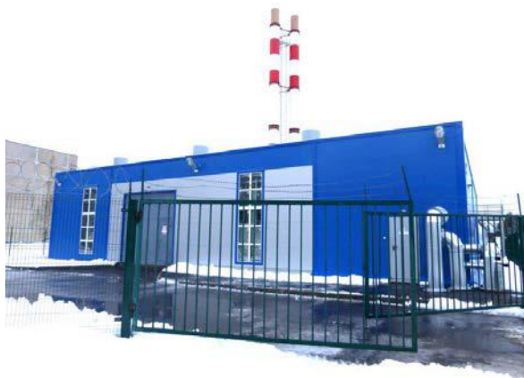
Рисунок 2 – Внешний вид котельной д. Заклинье
