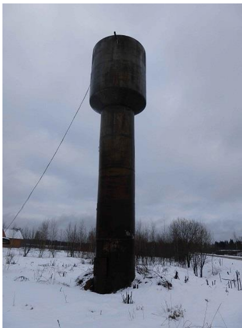
Рисунок 9 – Существующая водонапорная башня в д. Турово
