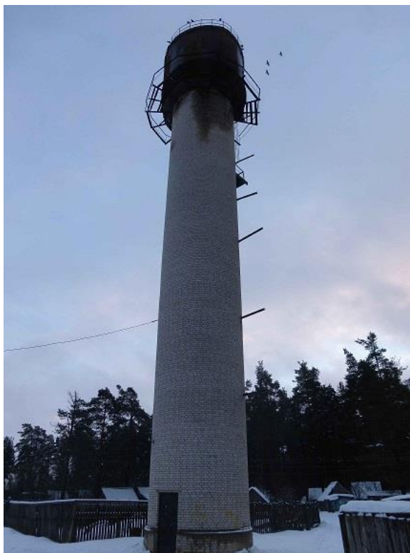
Рисунок 7 – Существующая водонапорная башня в д. Заклинье
