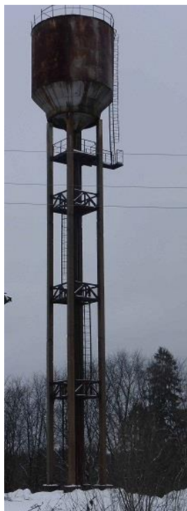
Рисунок 8 – Существующая водонапорная башня в д. Каменка
