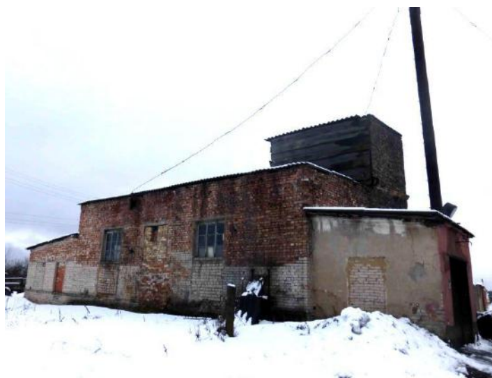
Рисунок 4 – Внешний вид котельной д. Турово
