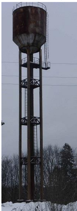
Рисунок 8 – Существующая водонапорная башня в д. Каменка
