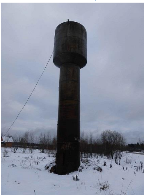
Рисунок 9 – Существующая водонапорная башня в д. Турово
