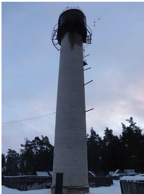
Рисунок 7 – Существующая водонапорная башня в д. Заклинье
