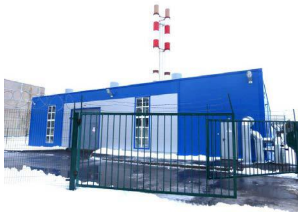
Рисунок 2 – Внешний вид котельной д. Заклинье
