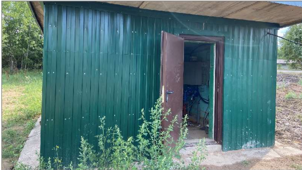
Здание скважины в д. Турово
