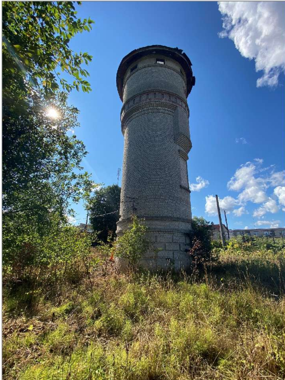
Водонапорная башня д.Заклинье.
