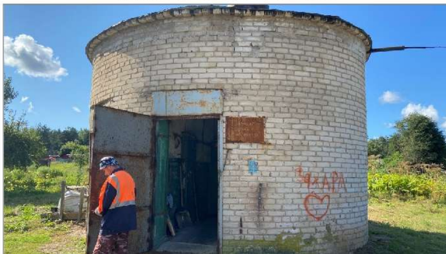
Комплексная насосная станция д. Заклинье.
