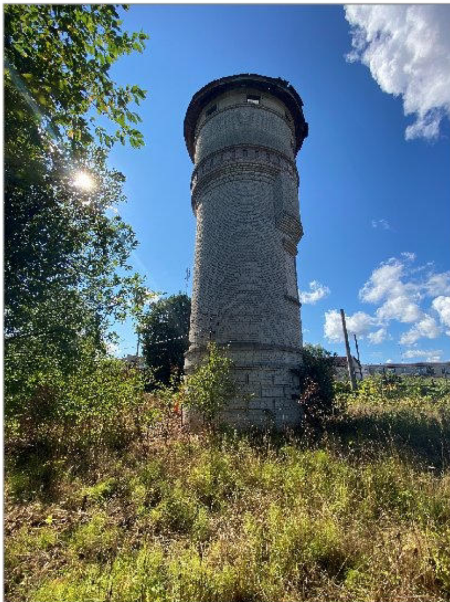
Водонапорная башня д.Заклинье.
