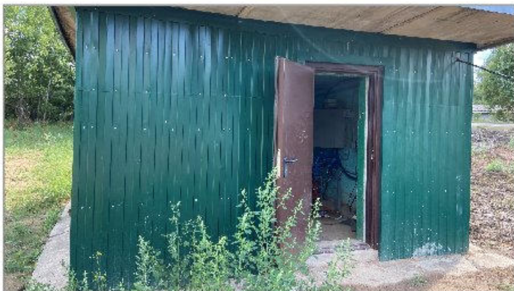
Здание скважины в д. Турово
